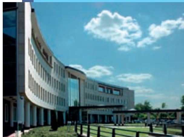
Budynek Centrali ZUS. Zbiory ZUS
