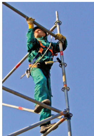
Fot. 1. Monter rusztowań.
