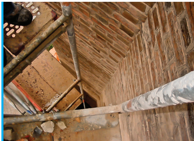
Fot. 7. Przykład pomostu roboczego niepełniającego wymogów bezpieczeństwa.
