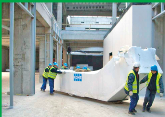
Stanowisko pracy przed zakupem podnośnika
