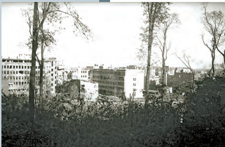
Zniszczona siedziba ZUS przy ul. Czerniakowskiej 231.
